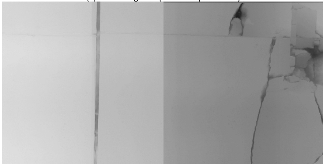
(d) Test image #4 (concrete pavement)
