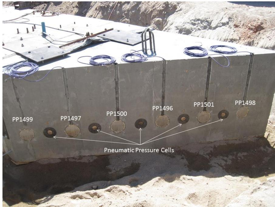
**FIGURE 5 Pile cap wedge interface.**
