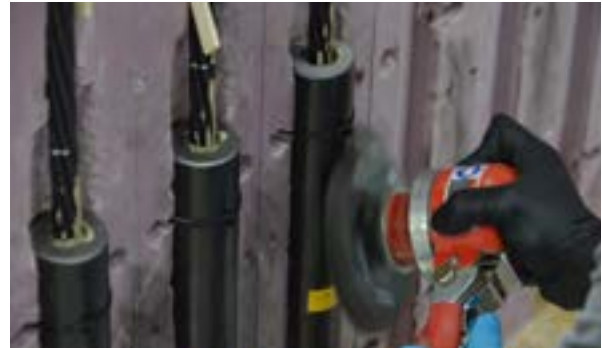
(d) Tap the sockets using air vibrator
